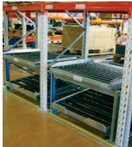
Stockage palettes au sol.
